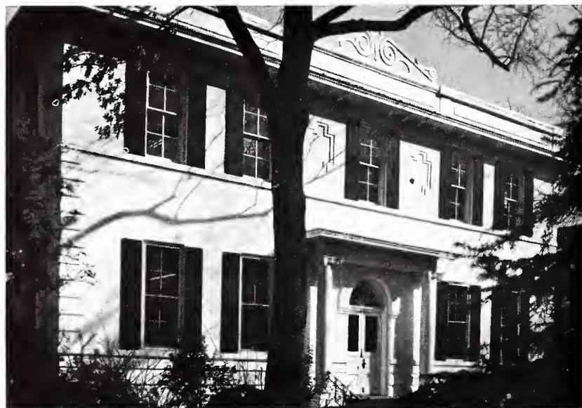
R. O. T. C. BUILDING
